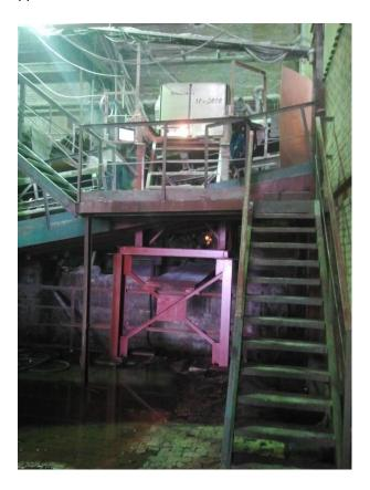
а. Для снижения уровня вибрации, передаваемых на МАҮА от конвейера анализатор установлен на специальной раме высотой 11 м, стоящей на бетонном основании и не имеющей контактов с металлоконструкциями самого конвейера.
